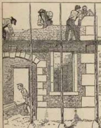
27. Maçons construisant une maison avec la *pierre à bâtir*. Les *moellons* (pierres non taillées) servent à faire les parties destinées à être recouvertes de *plâtre* (p. 18) ou de *mortier* (p. 11).
