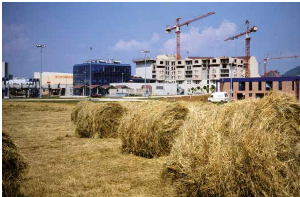
Le bâtiment des Archives départementales du Doubs et les immeubles du quartier de la place Cassin en cours de construction, 1986 (AMB, 26Fi11-33).
