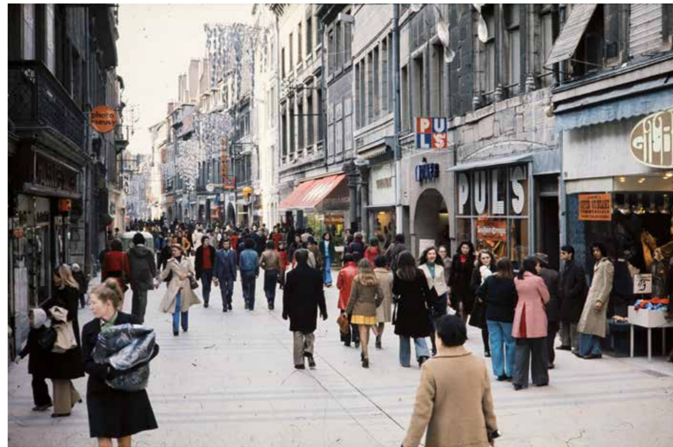
La même Grande Rue une fois les travaux terminés, 1975 (AMB, 26Fi99-22).
