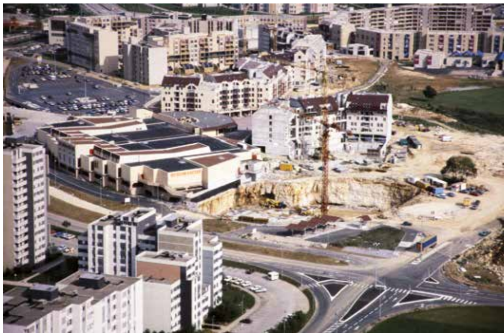
Le chantier de construction du bâtiment des Archives départementales du Doubs, [1985-1986] (AMB, 26Fi72-112). Ce chantier démarre alors que celui de la construction du supermarché de la place Cassin (actuel Intermarché) est achevé.
