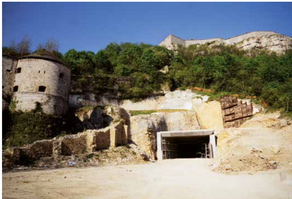
L'entrée du tunnel sous la citadelle côté Tarragnoz pendant les travaux d'aménagement du tunnel, [1994-1995] (AMB, 26Fi430-13).
