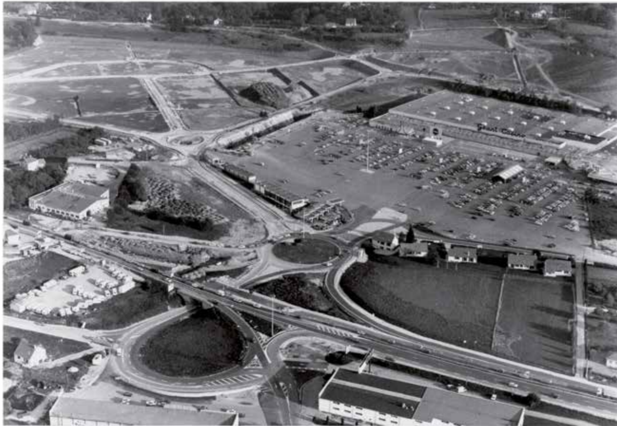
Le centre commercial de Châteaufarine en construction, 1989 (AMB, 6Fi263-03).
