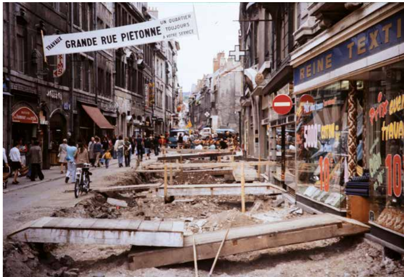
La Grande Rue au niveau de la place Pasteur pendant les travaux de piétonisation, 1974 (AMB, 26Fi99-20).
