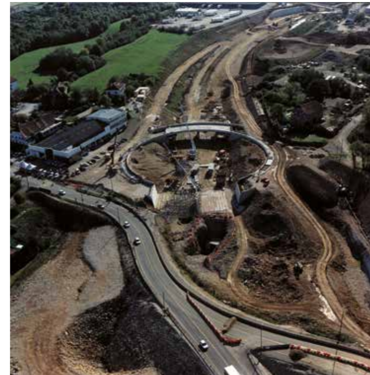
Vue aérienne de l'échangeur de Saint-Claude (rocade nord-ouest de Besançon) en cours d'aménagement, [2000-2002] (AMB, 6Fi1196-01).
