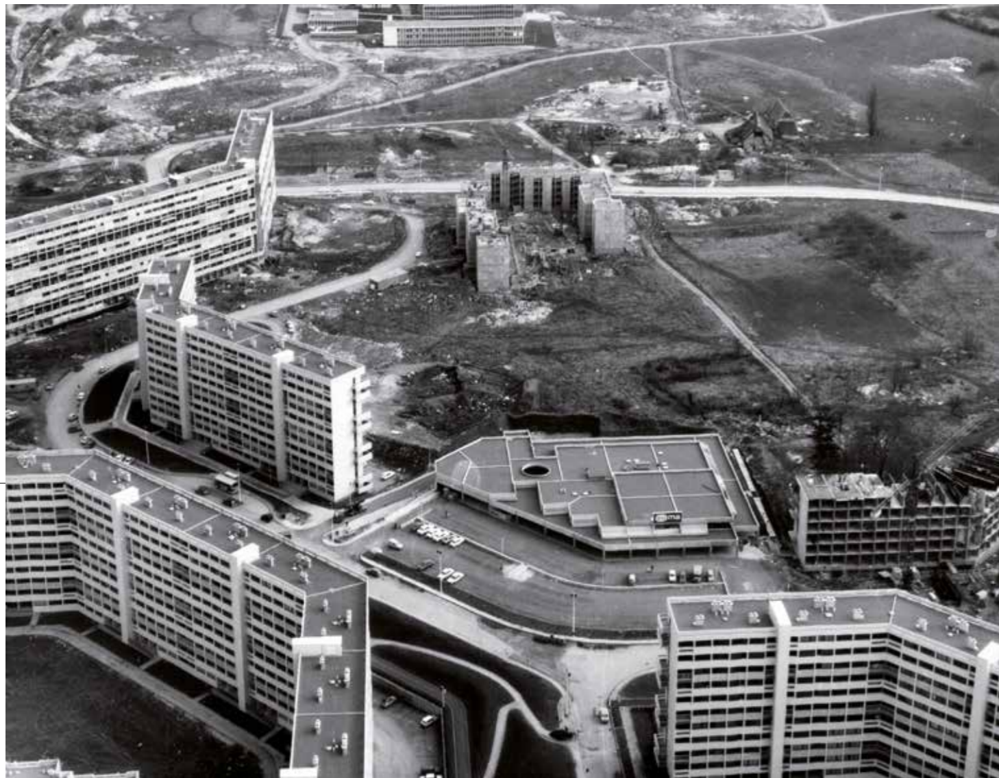
Vue aérienne du quartier des Époisses en construction avec au premier plan l'actuel supermarché Norma, [1969-1970] (AMB, 6Fi371-06).
