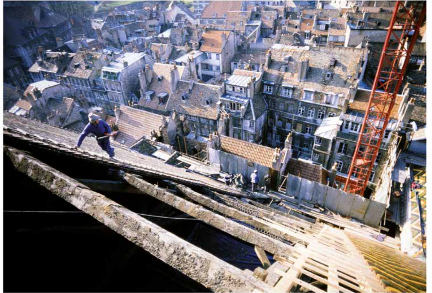
Travaux de réfection des charpentes et des toitures de l'église de la Madeleine, [2000] (AMB, 26Fi89-42).
