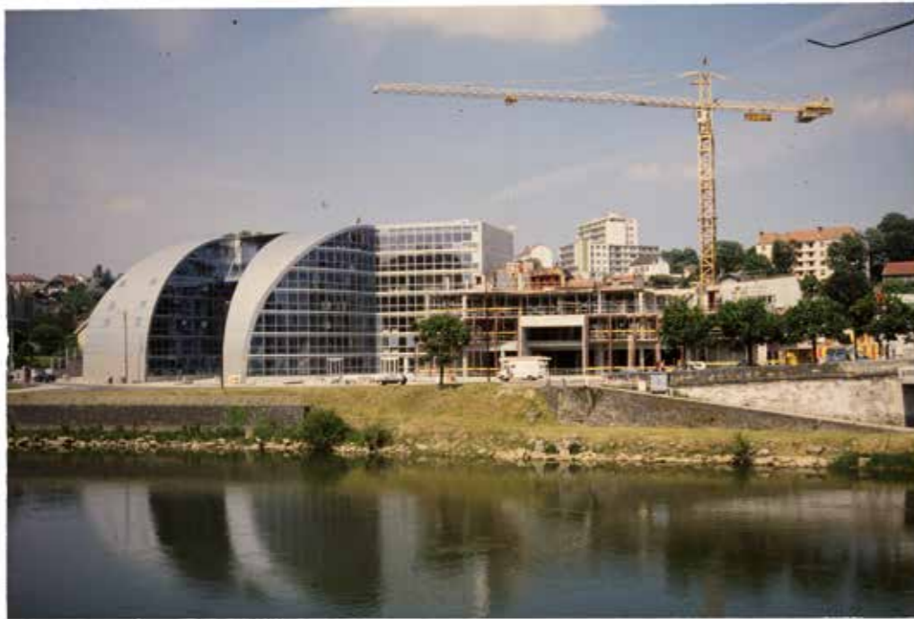
L'ensemble immobilier de la City, 1994 (AMB, 26Fi225-23). Les travaux de construction ont débuté en 1991.
