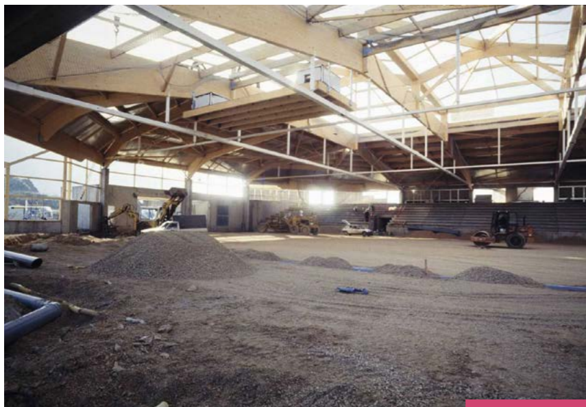
La patinoire Lafayette en construction, 1992-1993, Archives municipales de Besançon, 26Fi168-1 Dans une période de développement industriel, ces infrastructures construites en grand nombre sur le territoire national se standardisent. Les charpentes, métalliques ou en lamellé-collé, sont fabriquées en atelier et rapidement assemblées sur place.
