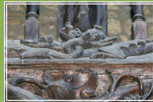
Ancien hospice du Saint-Esprit (galerie de la cour intérieure) 1-3, rue Goudimel
